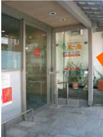
玄関先の深い軒は車の乗降に雨の日も安心
